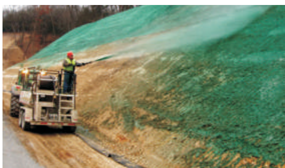
Figure 29: Hydroseeding to prevent erosion (Kulig Contracting)
